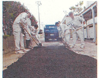
アスファルト舗装実習
