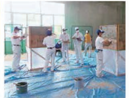
出前講座（型枠施工）
